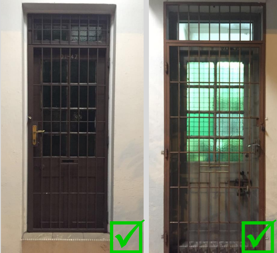
Original Timber-framed door Original mild-steel framed door
